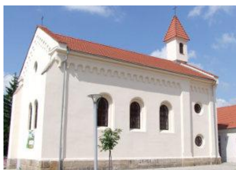
Bývalá věžeňská kaple
